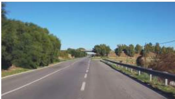
Foto 9. Strada statale Mazara – Campobello di Mazara.
